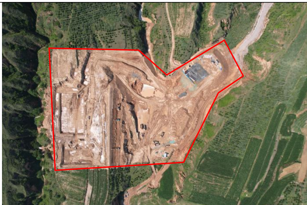
起点 200MW/400MWh 独立新型储能电站（在建）
