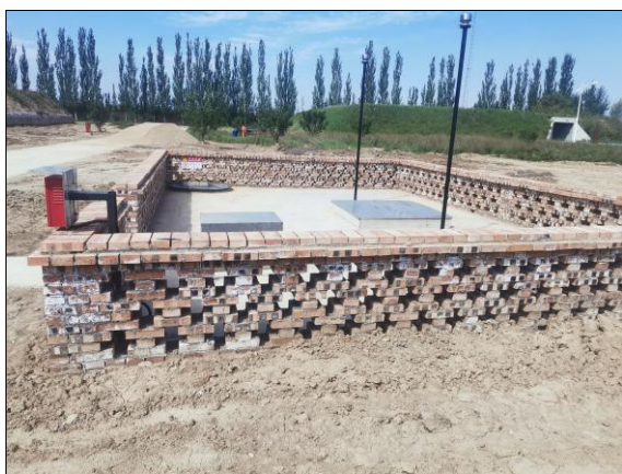
现有柴油储罐区
