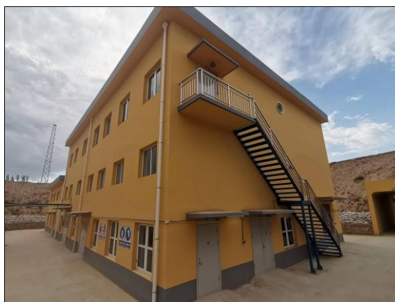
现有乳化粒状铵油炸药生产车间
