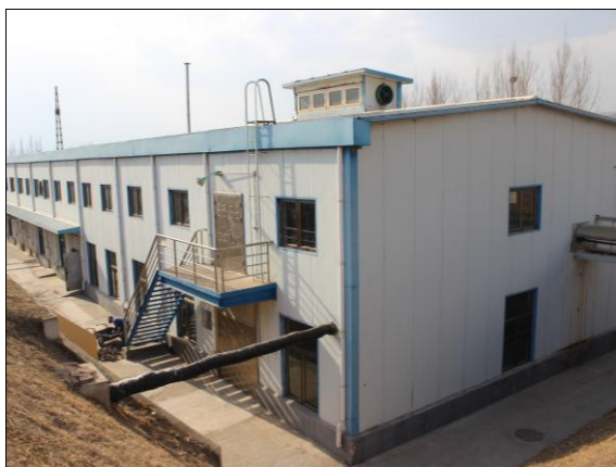
现有现有乳化炸药生产车间
