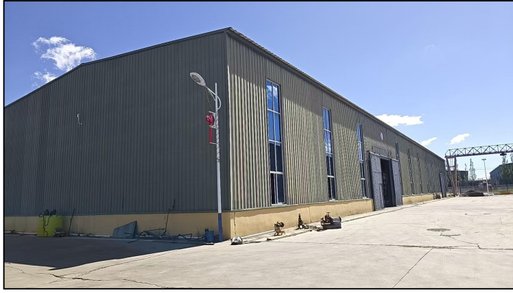
本项目生产车间
