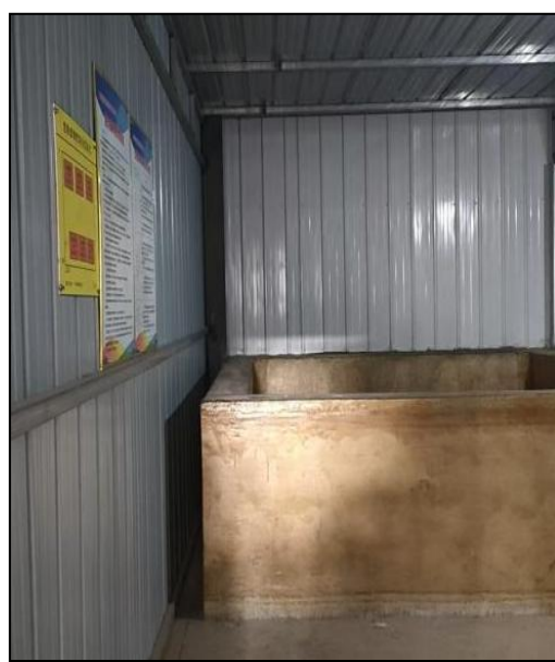
依托危废贮存库内部
