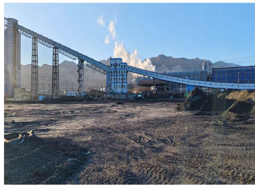
建设项目场地西侧
