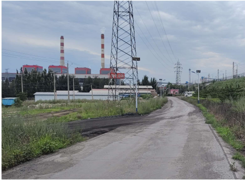
建设项目场地北侧
