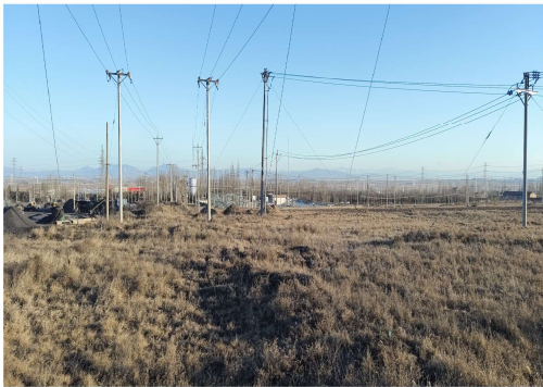
建设项目场地现状
