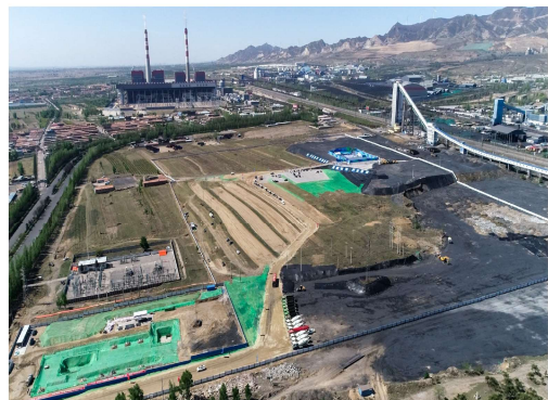
建设项目场地现状
