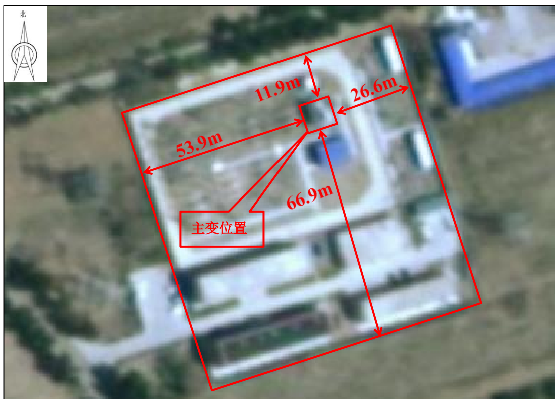
图1 浑源和庄 220kV 升压站
