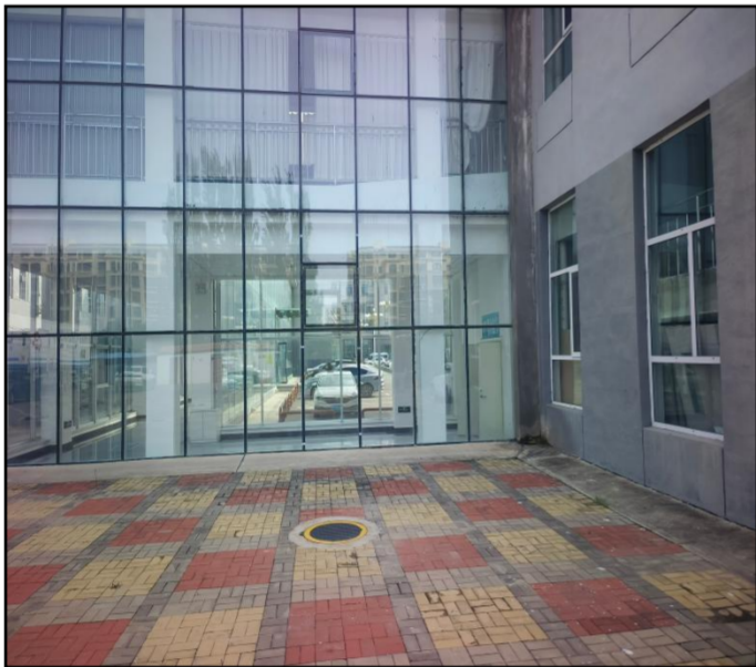
住院楼东侧（人员通道）
