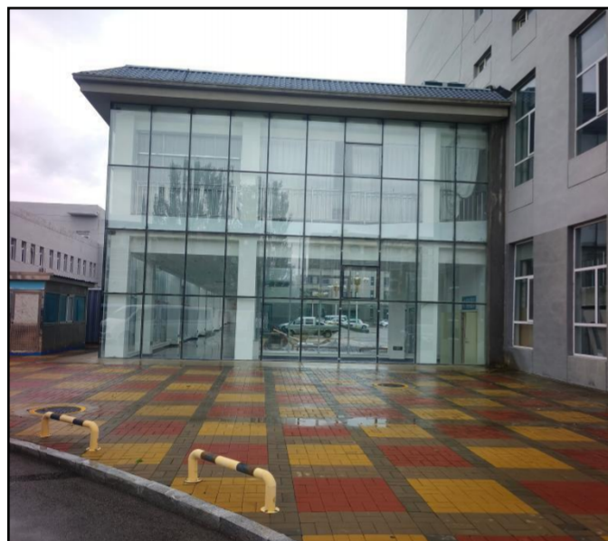
住院楼东侧（人员通道）
