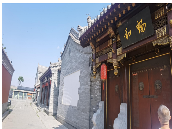
项目南侧占地现状
