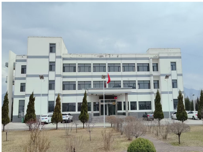
污水处理厂办公楼
