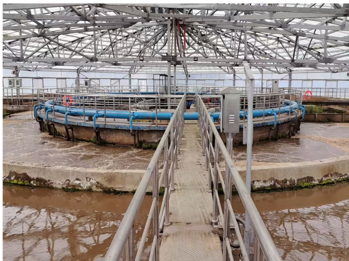
现有工程生化池
