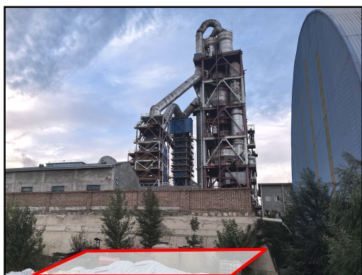
旁路灰水洗生产线现状
