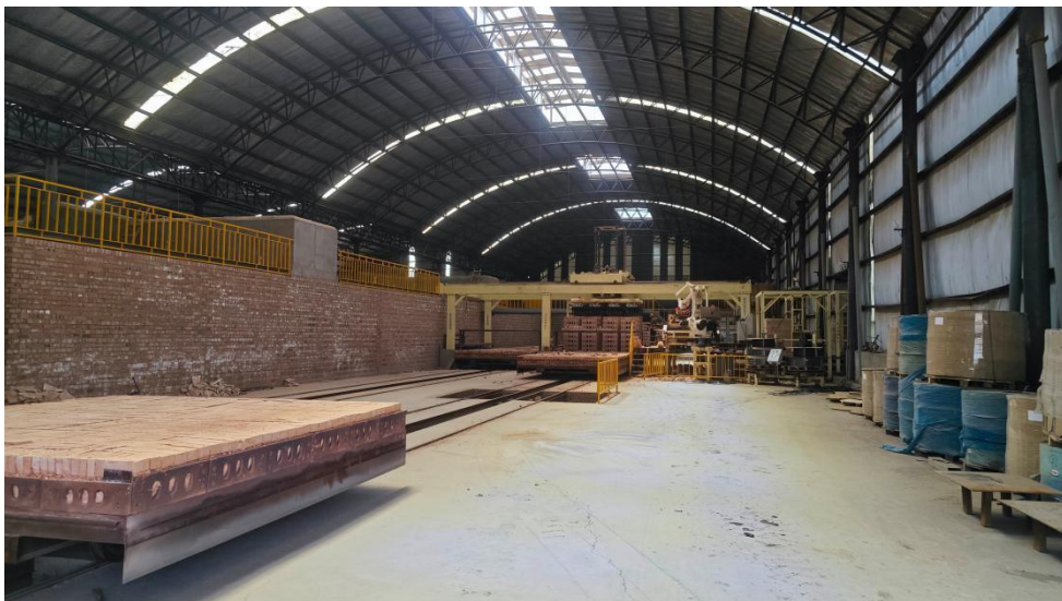
现有工程隧道焙烧窑
