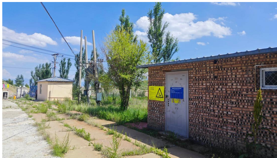
现有工程危废贮存间
