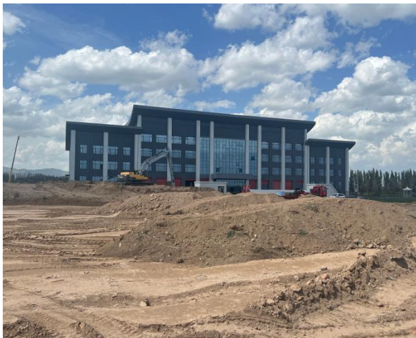
厂址北侧（消防站）
