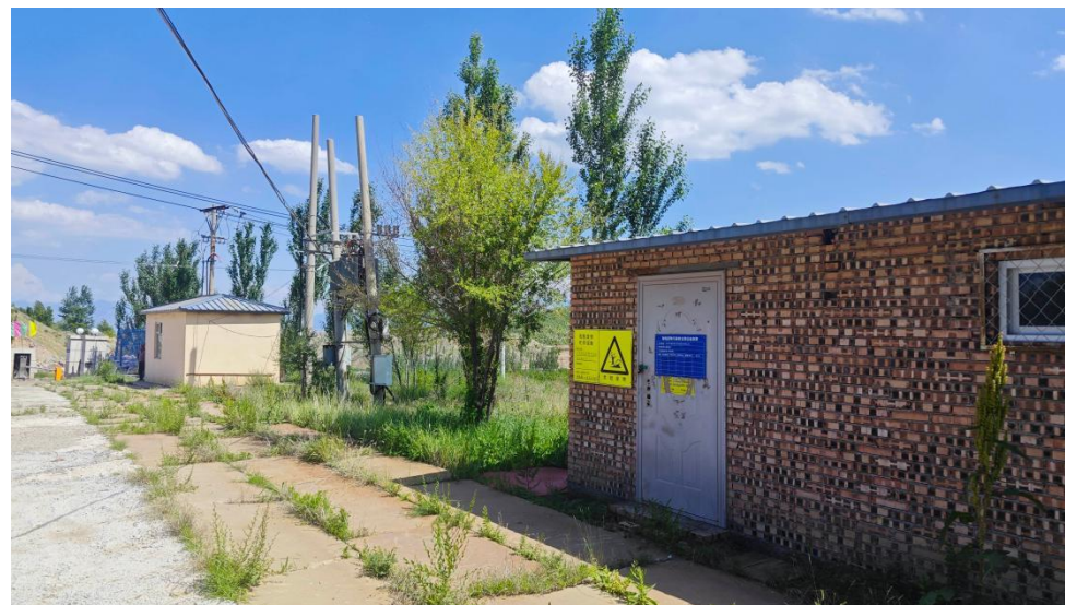
现有工程危废贮存间
