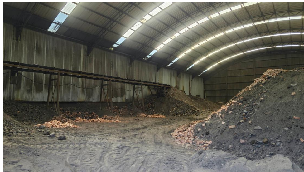
现有工程原料库
