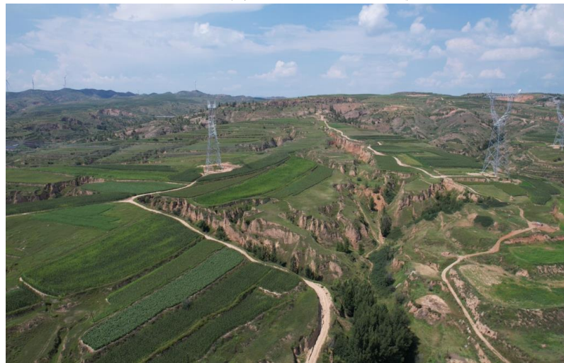
线路沿线地貌
