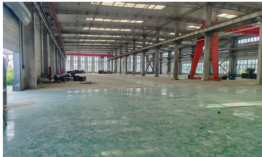
租赁生产车间内部概况
