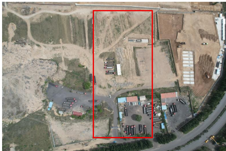
起点储能电站现状
