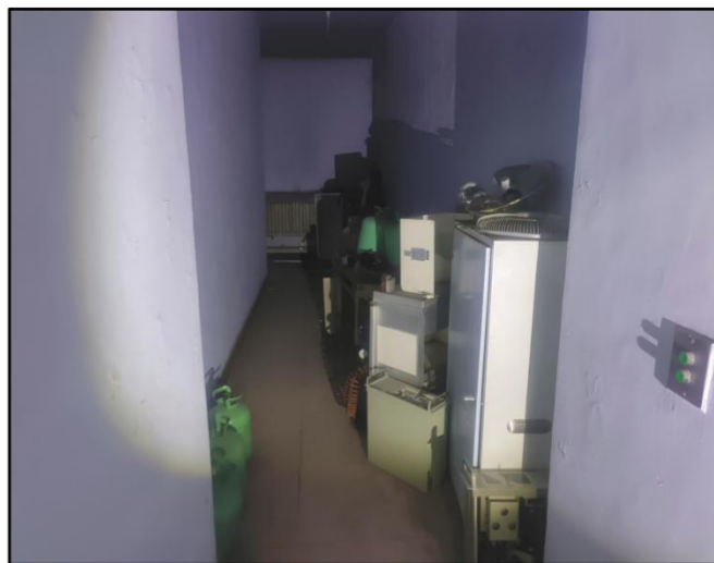
直线加速器 2 室迷道
