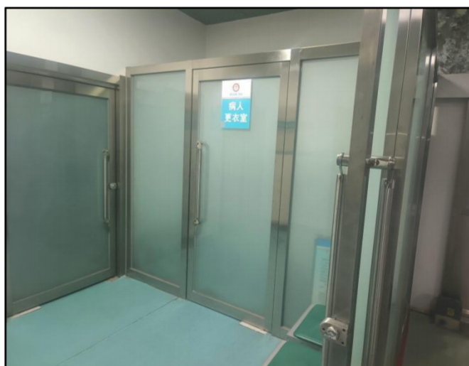
直线加速器 2 室东侧（更衣间/设备机房）
