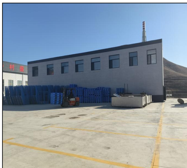
污水处理站外部
