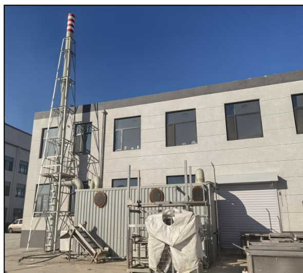
废气处理装置（生物除臭净化塔）
