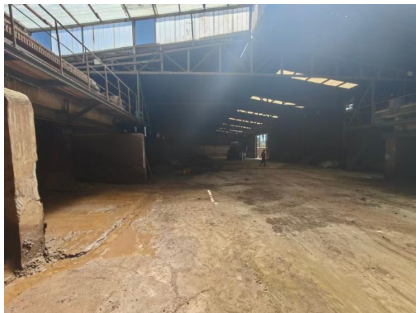
现有工程车间内部
