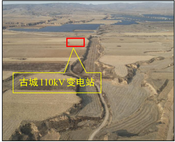
古城 110kV 变电站站址现状
