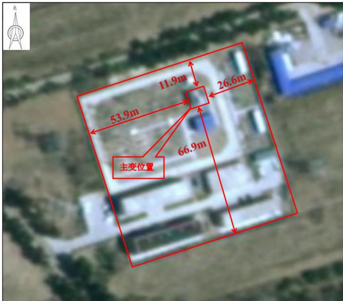
图 1 浑源和庄 220kV 升压站
