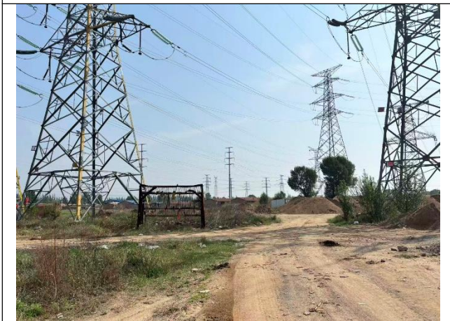
架空线路走廊
