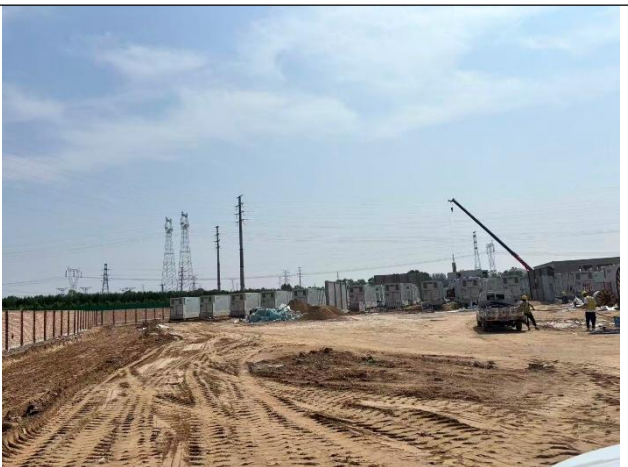
储能电站（在建）
