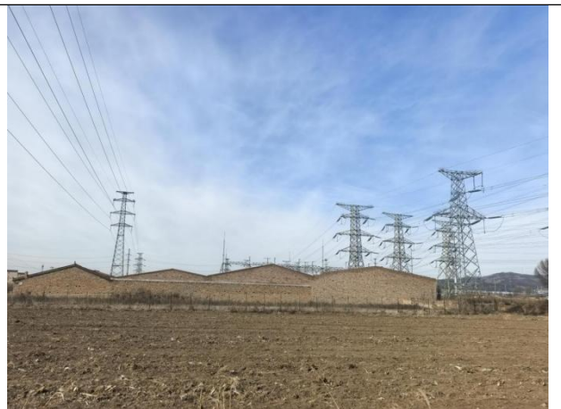
架空线路走廊
