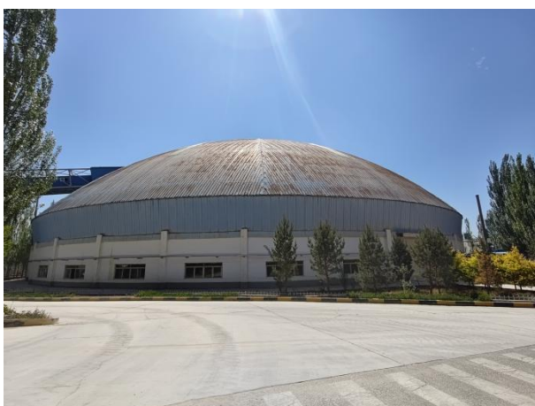
水泥原料入石灰石预均化堆棚
