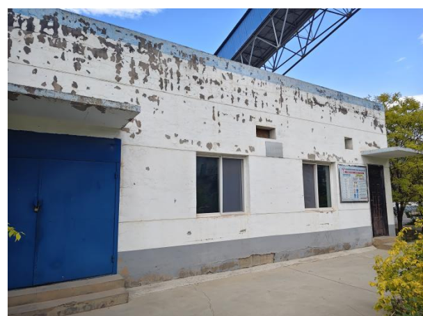
生活污水依托现有污水处理站
