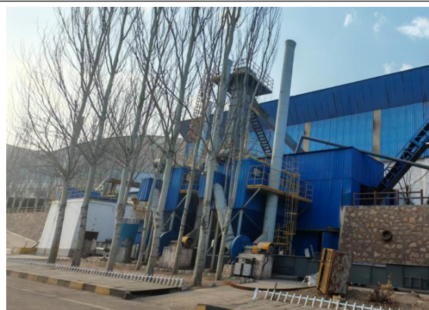
拟建机制砂场地（利用现有生料辅破工棚）
