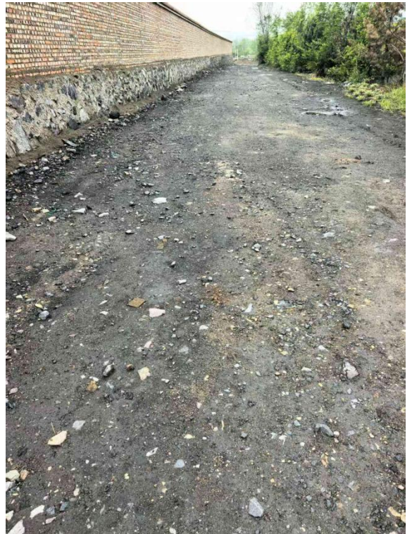
项目厂址东侧围墙
