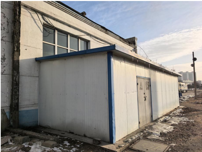
厂区现有危废暂存间现状
