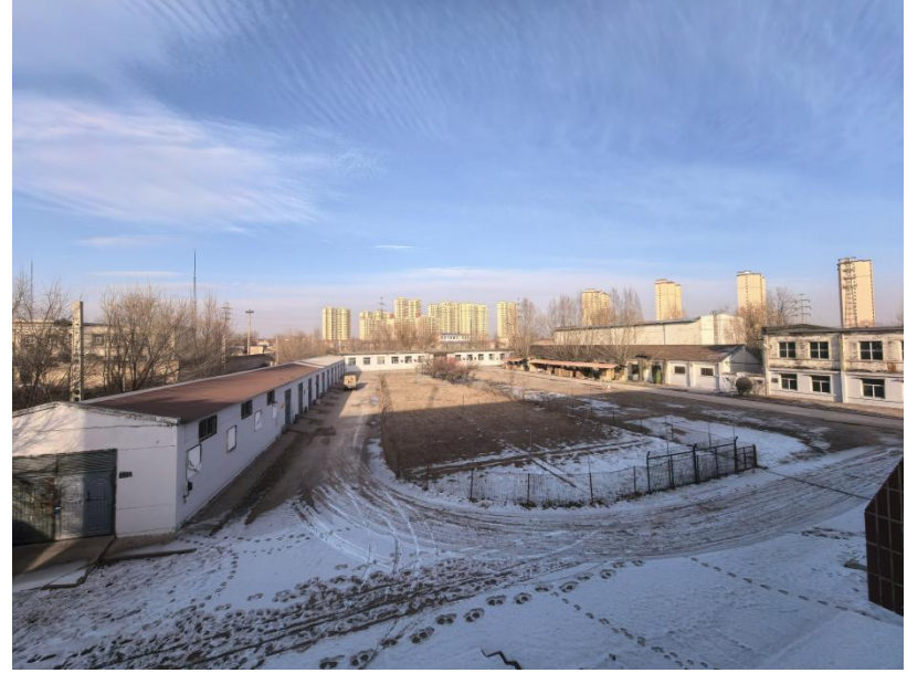
建设厂区现状
