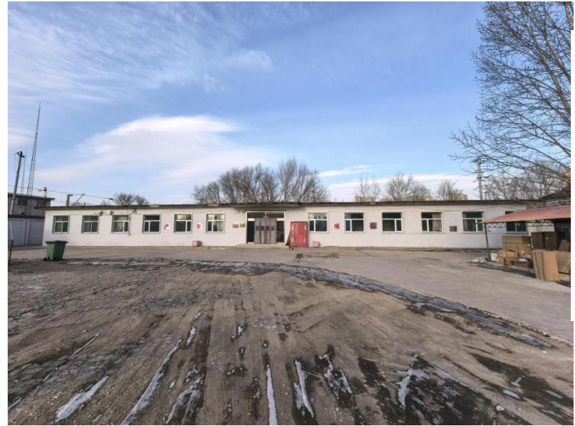
建设厂区现状
