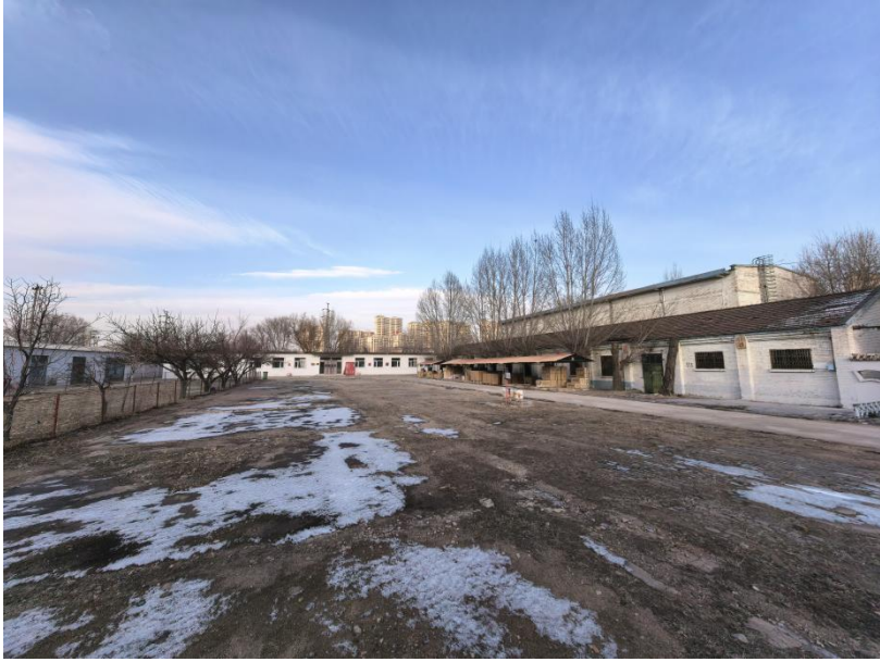
建设厂区现状
