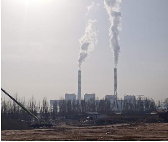
储能电站站址南侧
