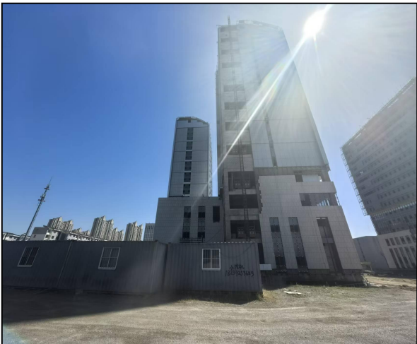
场地内 5#、6#楼现状
