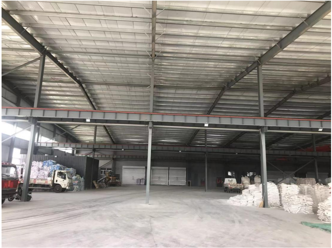
图 3-1 生产车间地面硬化照片
