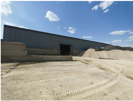
现有全封闭原料库
