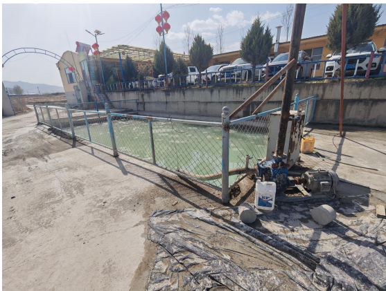
生产废水沉淀池
