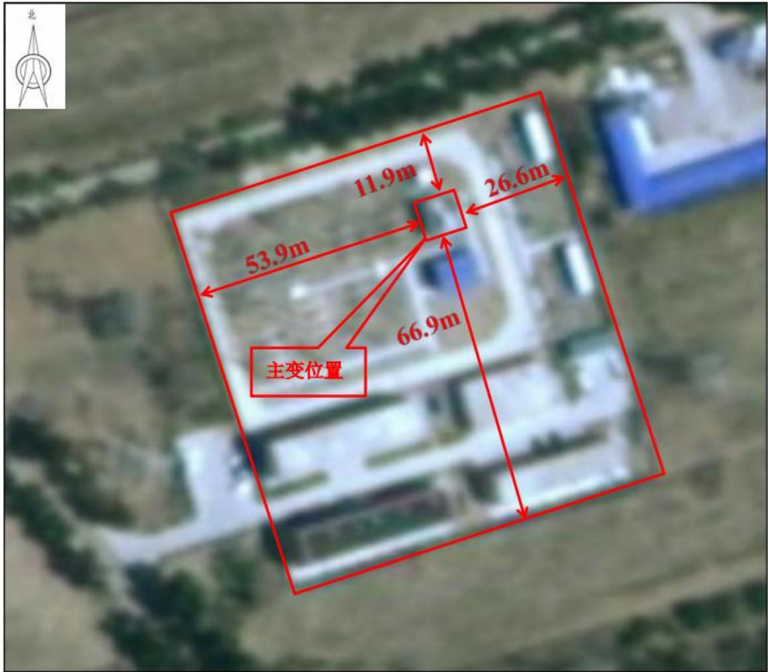
图 1 浑源和庄 220kV 升压站
