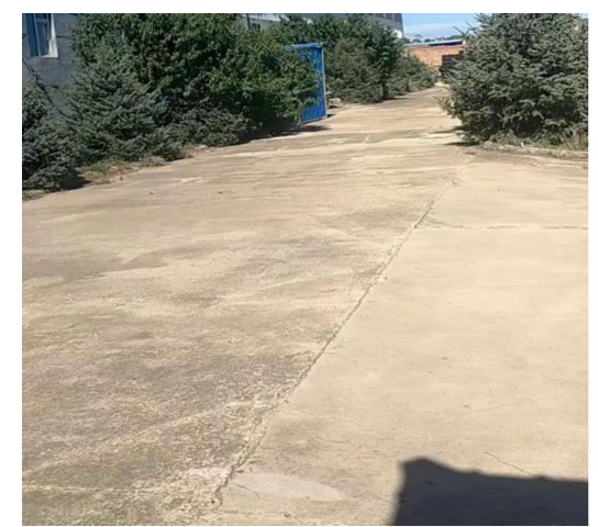
厂区地面硬化
