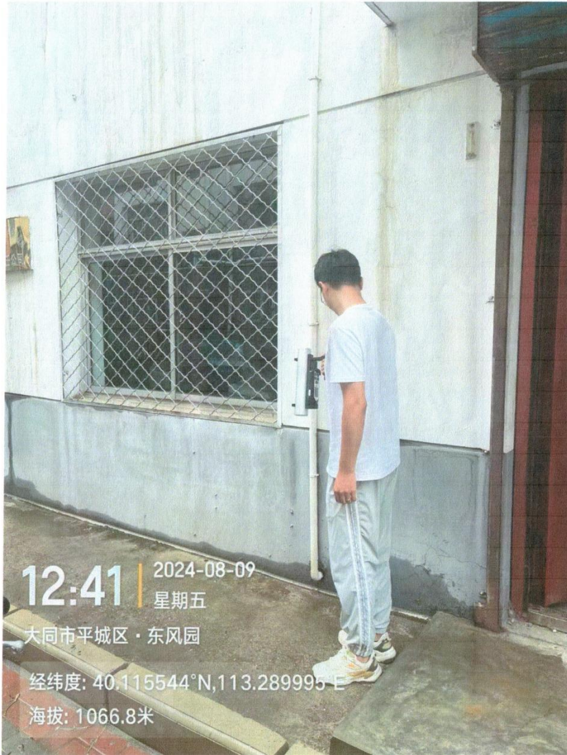
检测现场照片
