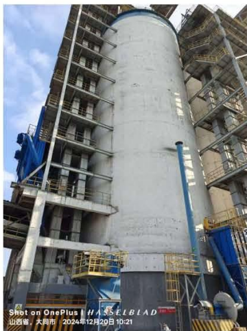
水泥来源（厂内水泥库）
