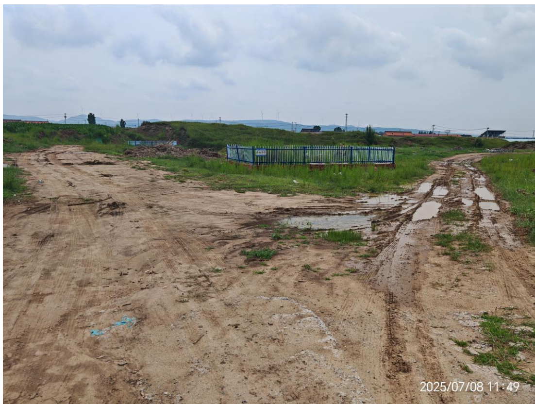
污水处理站厂址现状
