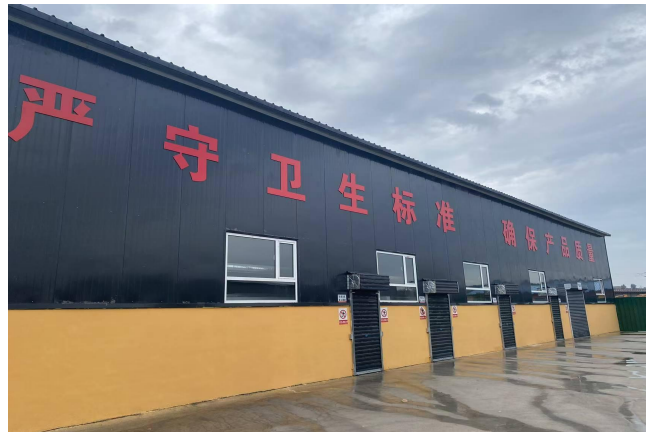
厂区现状（屠宰车间）
