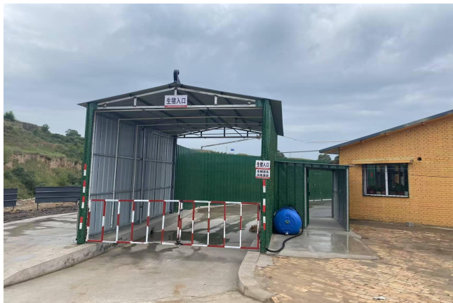
厂区现状（生猪入口）
