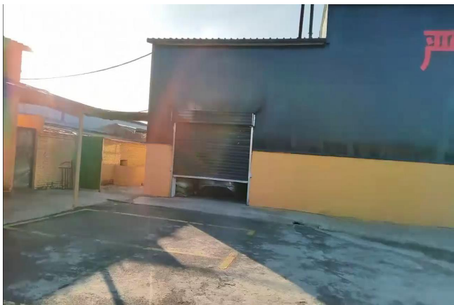
厂区现有锅炉房
